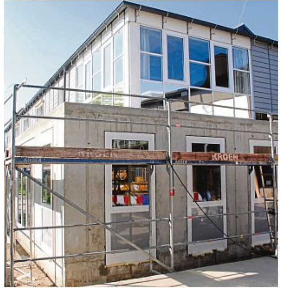
Bürgerhaus nimmt Form an Die Bürgerhaussanierung nimmt Gestalt an. Inzwischen wurde der Wintergarten abgerissen. Er entsprach in keiner Weise den Brandschutzvorschriften. Ihn ersetzt ein fester Bau mit einer Fensterfassade. Dieser wird nach dem Anbringen der Wärmedämmung verkleidet wie die Hauptfassade des Bürgerhauses. FOTO: BARTMANN
