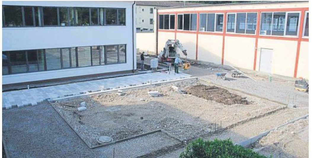
Das Rathaus-Umfeld (auf dem Foto der westliche Teil) wird umgestaltet. Die Rad- und Gehwegumleitung führt bis zur Fertigstellung an der Schulturnhalle vorbei. FOTOS (2): BARTMANN
