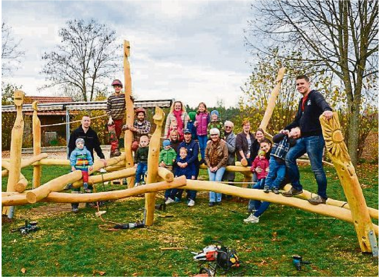
Alle haben beim Aufbau des Baumstamm-Mikados kräftig mit angepackt: Eltern, Großeltern, Erzieher und Kinder sowie zwei Mitarbeiter einer Olchinger Spielplatzbau-Firma. TB-FOTO
