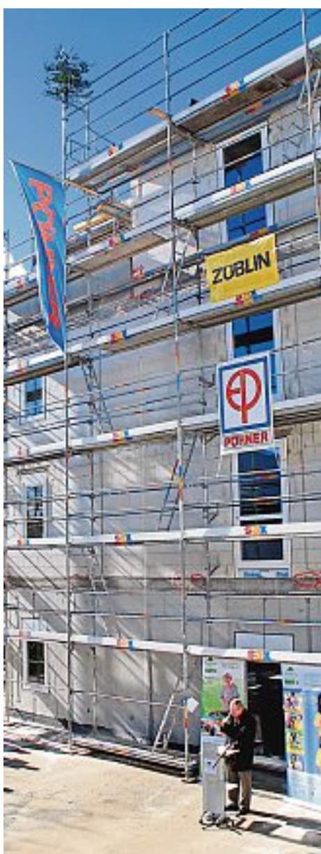
Richtfest am St.-Hildegard-Haus.
