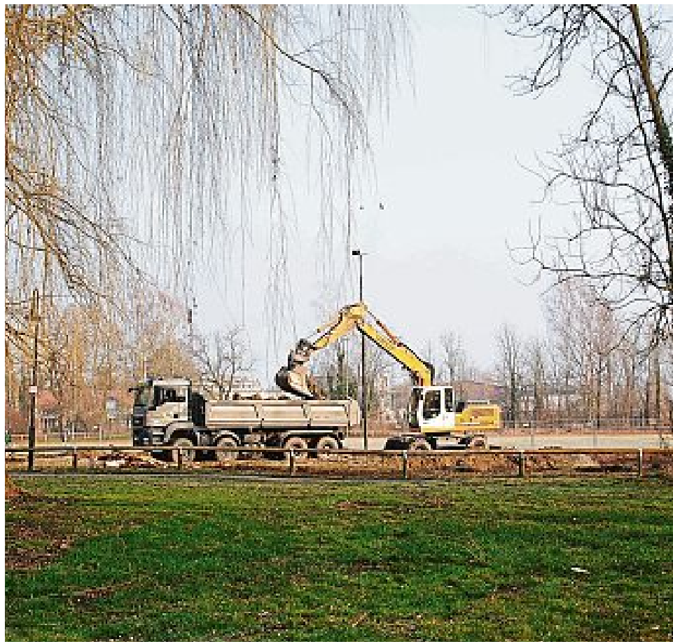
Die ersten Arbeiten für das Kinderhaus zwischen Feuerwehr und Sportplatz sind angelaufen. FOTO: BARTMANN
