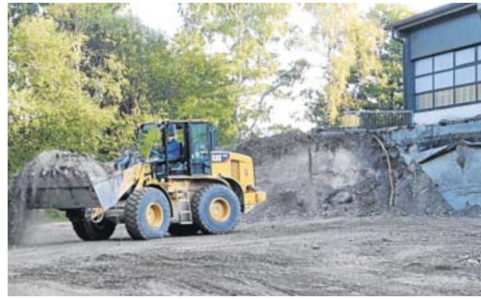
Wieder ein Baustelle: die Amperhalle.
