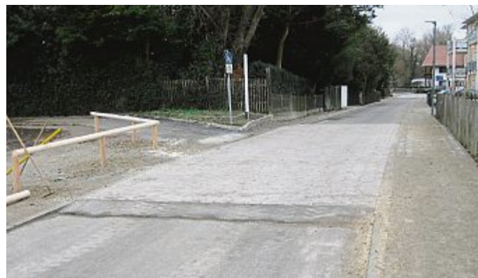
Im Frühjahr wird am Lauscherwörth weiter gebaut.
