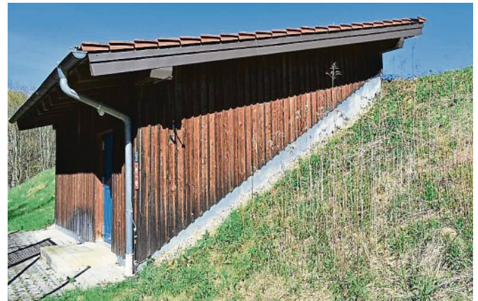
2009 Der neue Hoch- beziehungsweise Tiefbehälter ist in der Erde versenkt.
