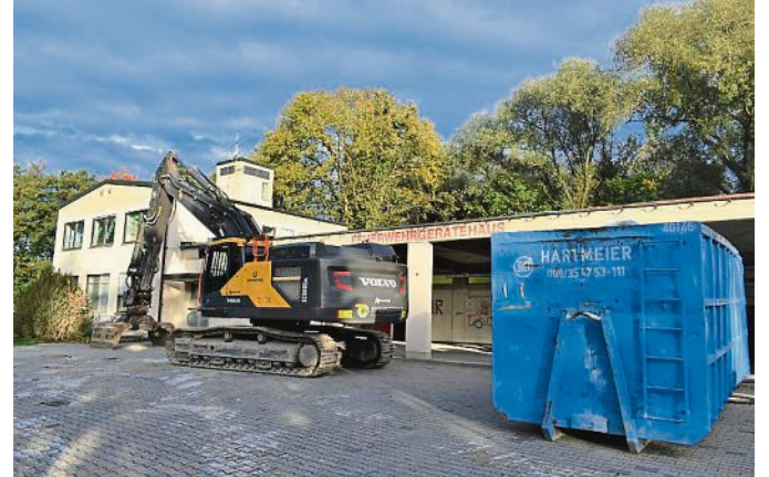
2019 Die Abrissarbeiten am Feuerwehrgerätehaus beginnen.
