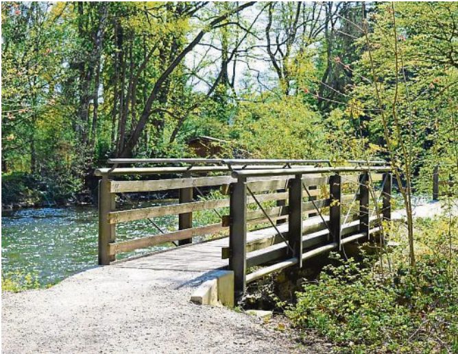
2014 Erneuerung der Brücken im Emmeringer Hölzl
