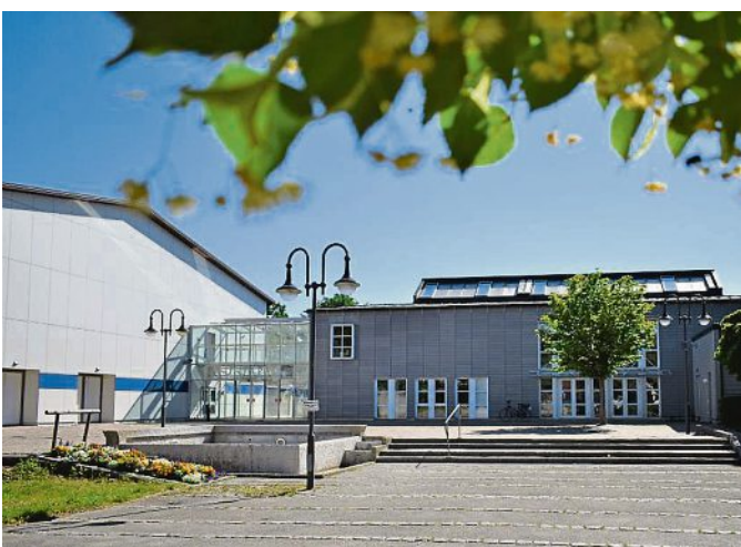
2016 Sanierungsarbeiten am Bürgerhaus und an der Amperhalle
