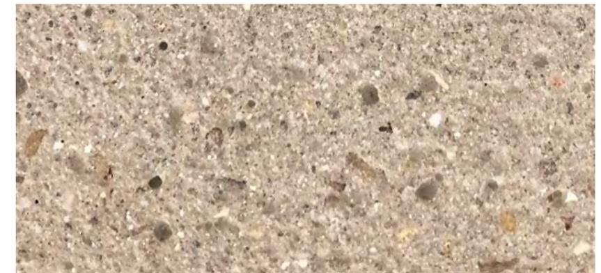
Betonpalisaden oder Fertigteil, Oberfläche gestraht
