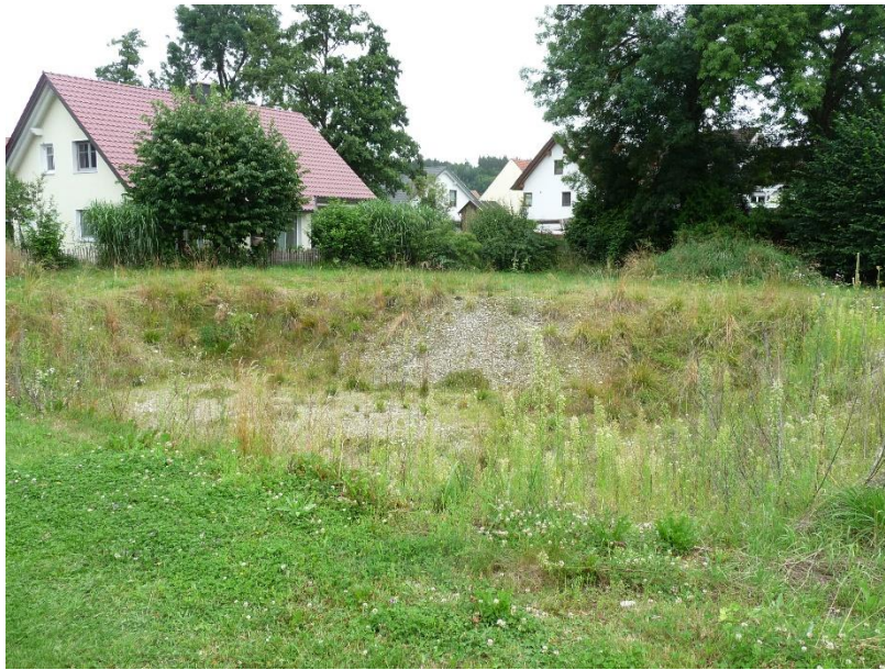
Abbildung 5: Plangebiet Blick über die Baugrube Richtung Süden
