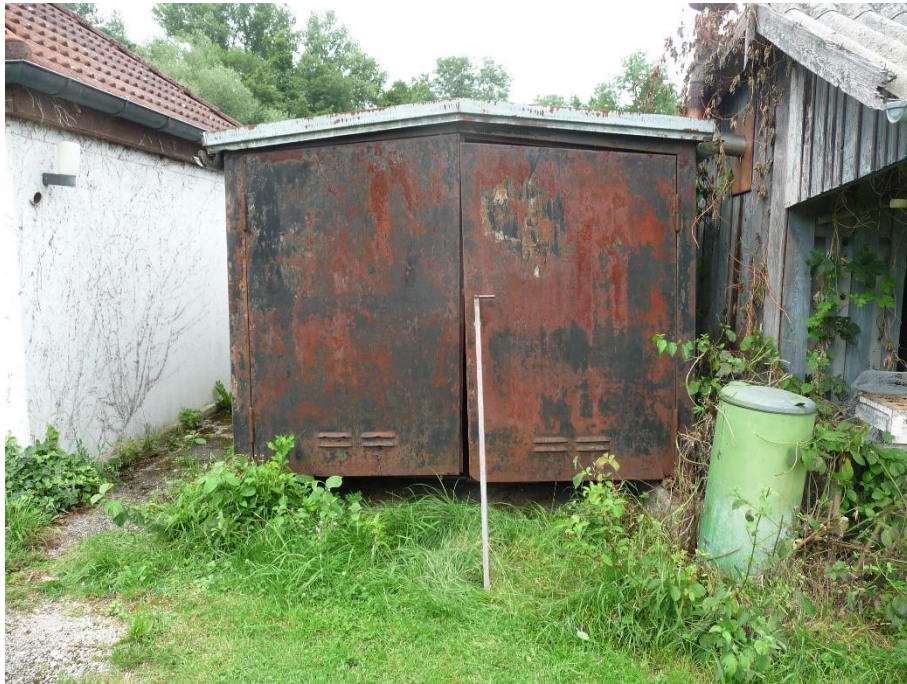
Abbildung 7: Metallgarage mit unten offenem Türbereich
