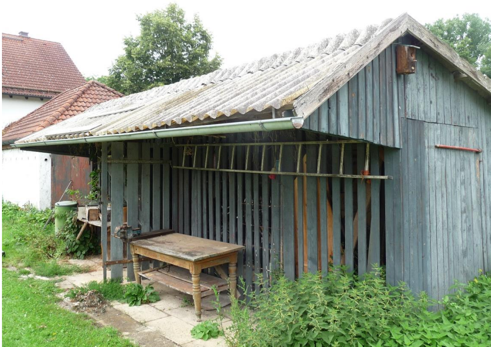
Abbildung 8: halboffene Scheune im Plangebiet (mit Vogelnistkasten an der Ostfassade)
