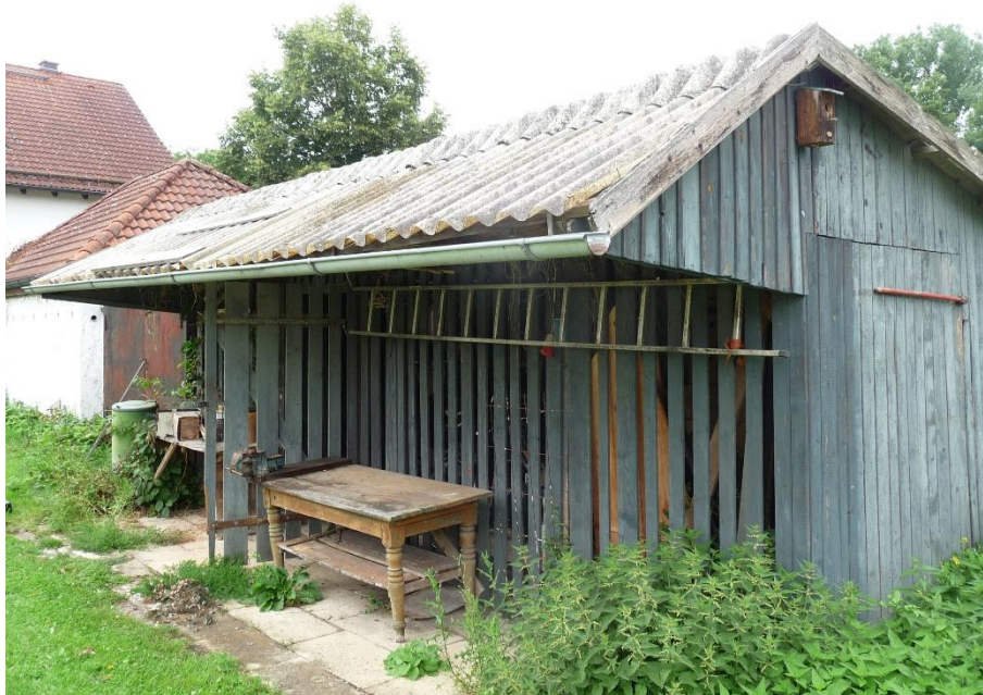
Abbildung 16: Holzscheune, Südseite (dort wo die Leiter hängt)
