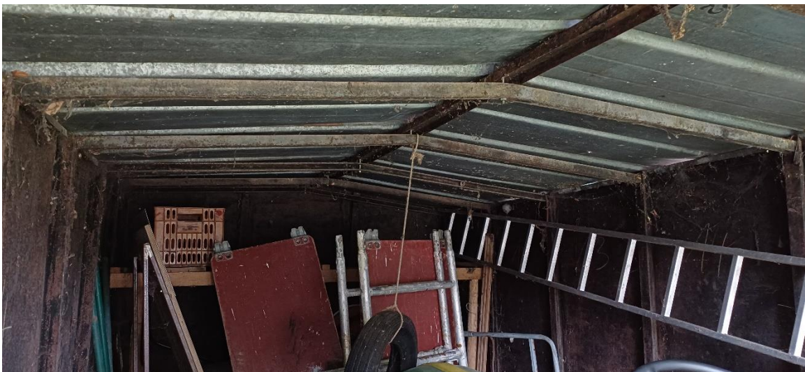
Abbildung 20: Innenbereich der Metallgarage
